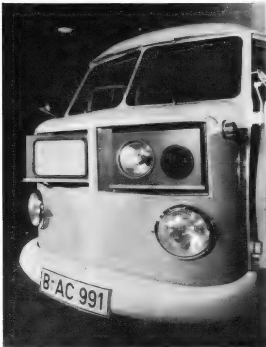
Links: Warnung an alle Kraftfahrer: Dieser Wagen mit Polizei-Verkehrsradar mißt die Geschwindigkeit der Kraftwagen und fotografiert mit einem Foto-Blitzgerät das Kennzeichen
